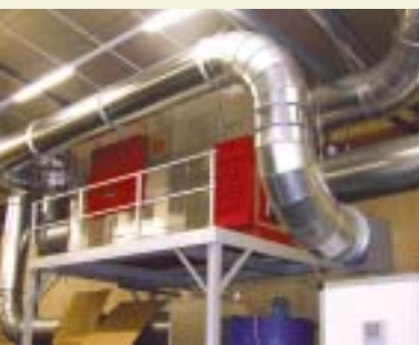
Ventilatie met warmtepomp
